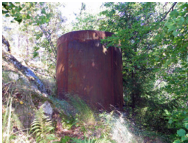
Lämningar av Montelius äventyrsgrotta. Stenvalvet som var ingång och vattenreservoaren ovanför gav självtryck till grottan. Det är enbart på föreningens tomt, industritomten, några lämningar finns kvar.
